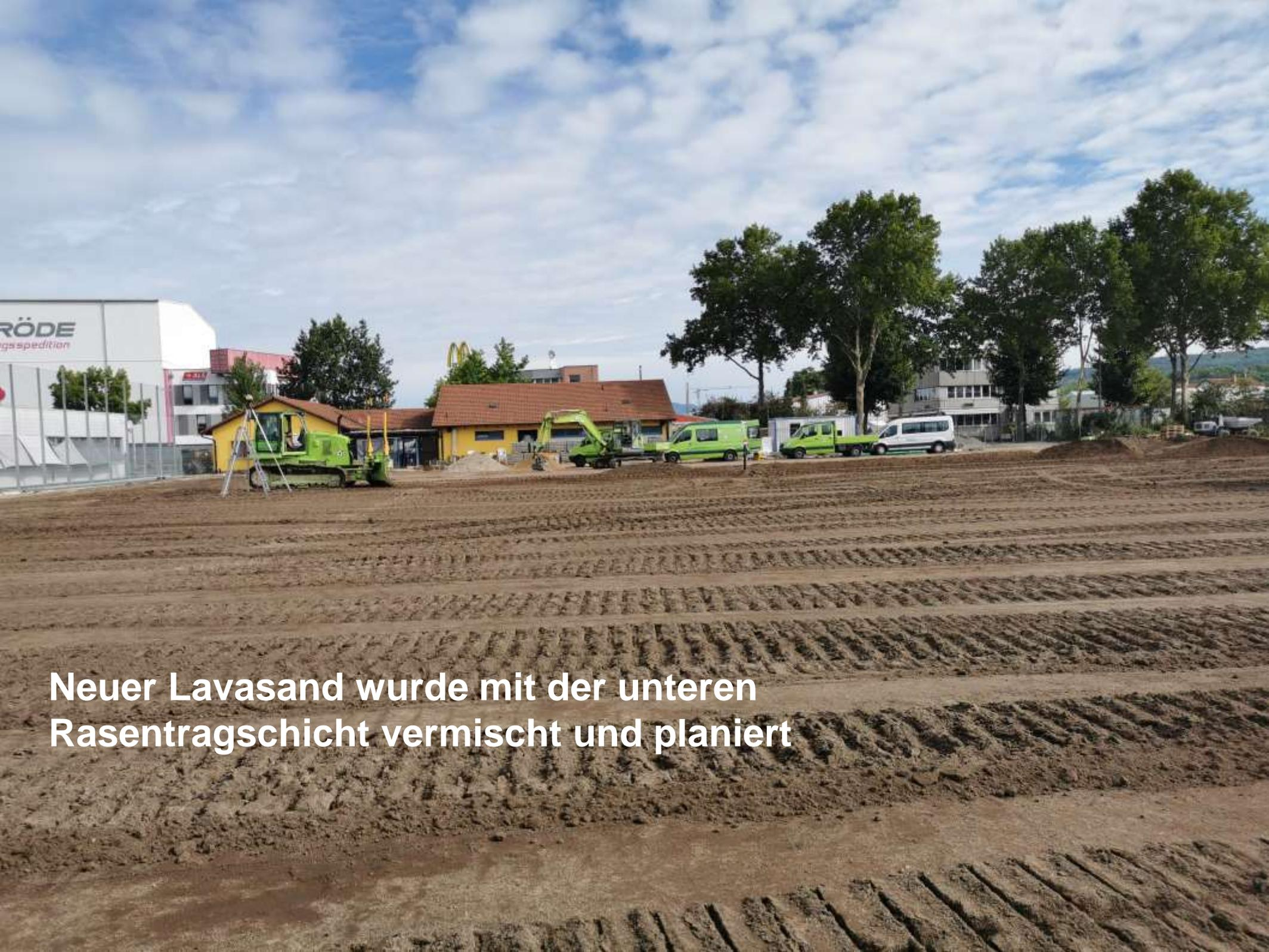
**Neuer Lavasand wurde mit der unteren Rasentragschicht vermischt und planiert**
