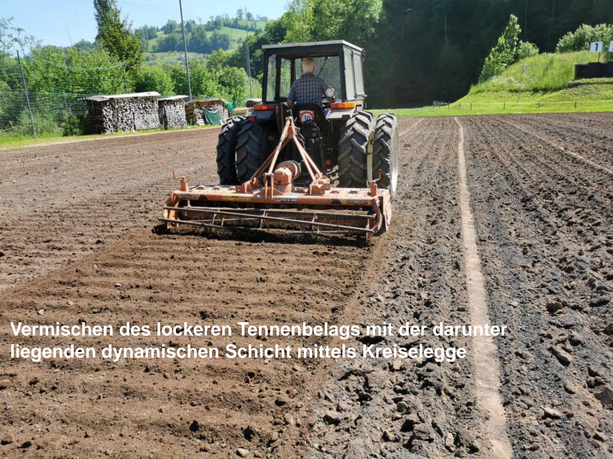
Vermischen des lockeren Tennenbelags mit der darunter liegenden dynamischen Schicht mittels Kreiselegge
